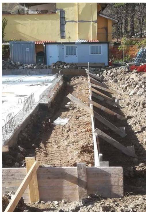
Completamento del piano terra con realizzazione del marciapiede intorno al fabbricato e preparazione finale degli appoggi delle strutture verticali
