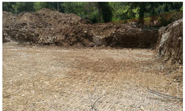
Fasi dello scavo con preparazione del vano di alloggiamento delle travi di fondazione
