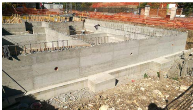
Rimozione dei casseri in legno e realizzazione dell'isolamento
