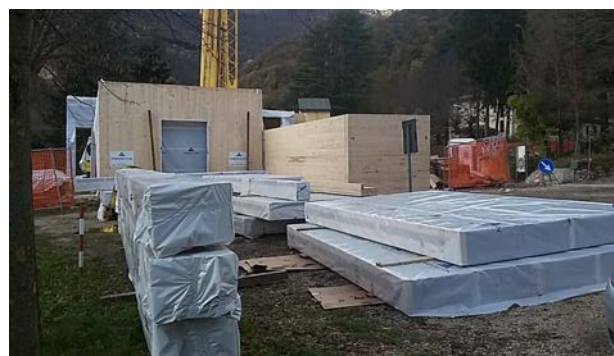
Completamento del piano terra con realizzazione del marciapiede intorno al fabbricato e preparazione finale degli appoggi delle strutture verticali
