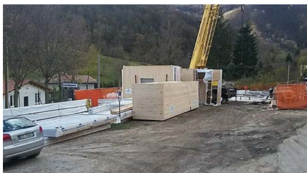
ARRIVANO LE STRUTTURE VERTICALI IN LEGNO
