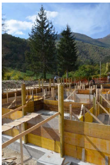
Ulteriore getto della parte alta di fondazione
