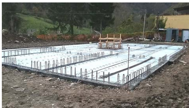
Posa dei tegoli per realizzare il piano terra
