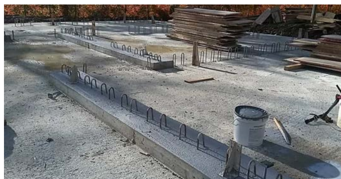
Completamento del piano terra con realizzazione del marciapiede intorno al fabbricato e preparazione finale degli appoggi delle strutture verticali
