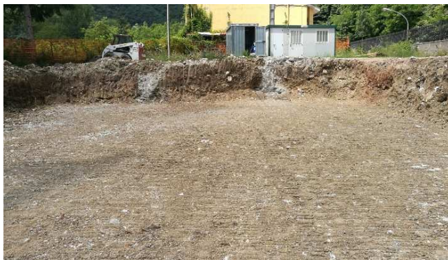
Fasi dello scavo con preparazione del vano di alloggiamento delle travi di fondazione
